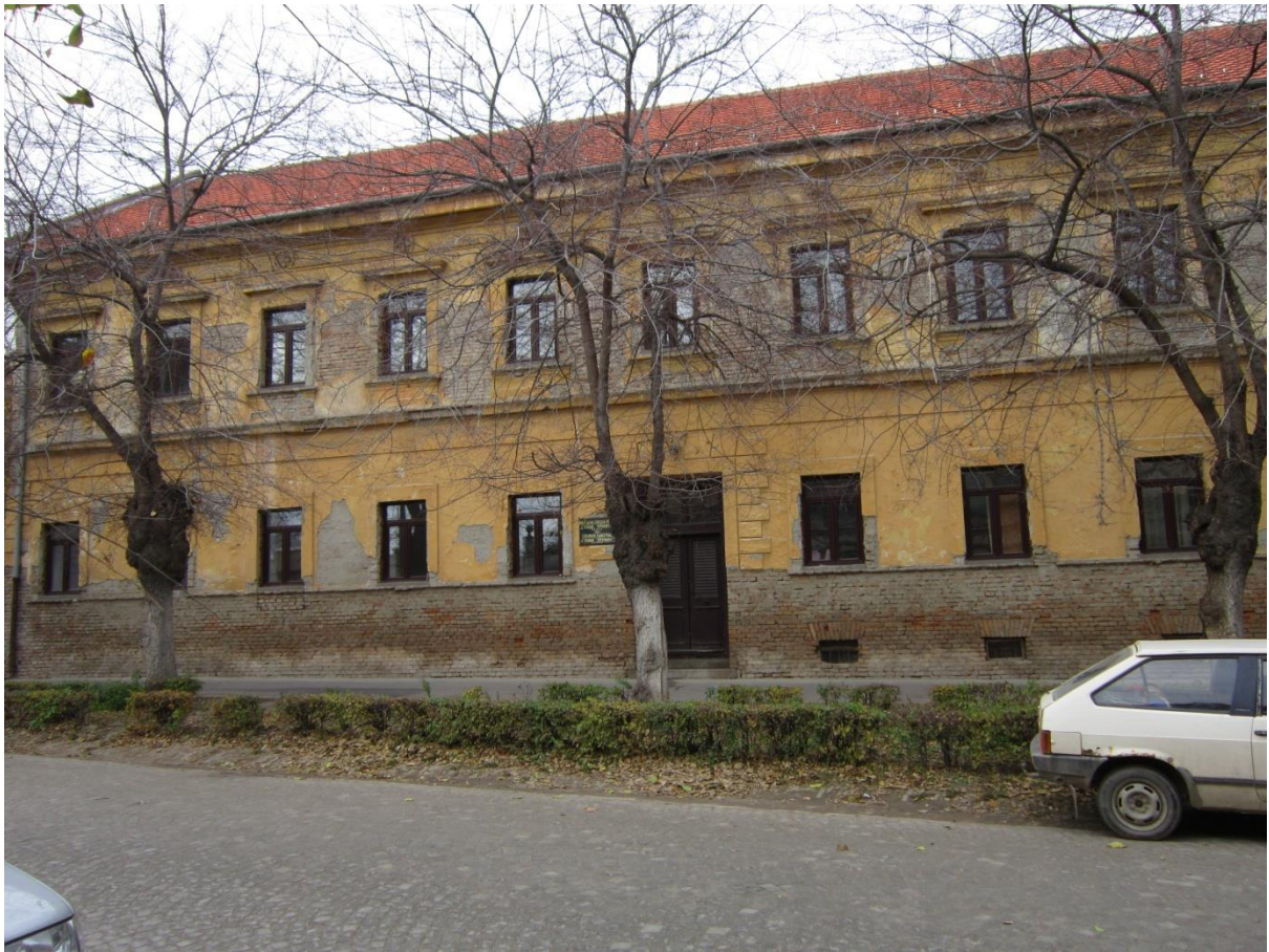
Објект пре уклањања фасаде
